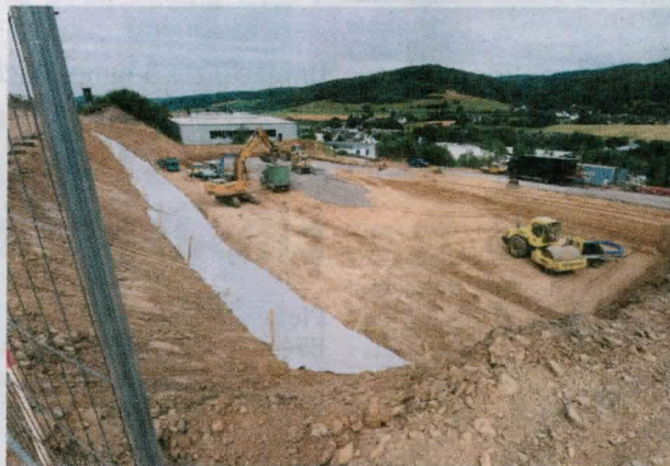
Die Firma Steelline baut ein neues Firmengebäude im Industriegebiet Köbbinghauser Hammer.
